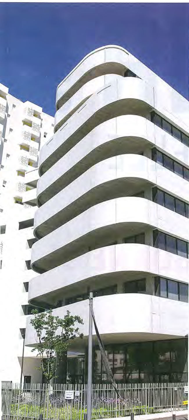
Expérimental. L'agence de Corinne Vezzoni a réalisé cet immeuble de bureaux situé dans l'îlot Allar, avec un béton écologique.
