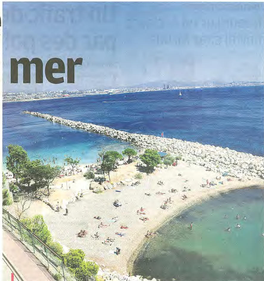
Aménagées dans les années 90, les plages de Corbières sont rapidement devenues sous-dimensionnées. / ARCHIVES DAVID ROSSI
