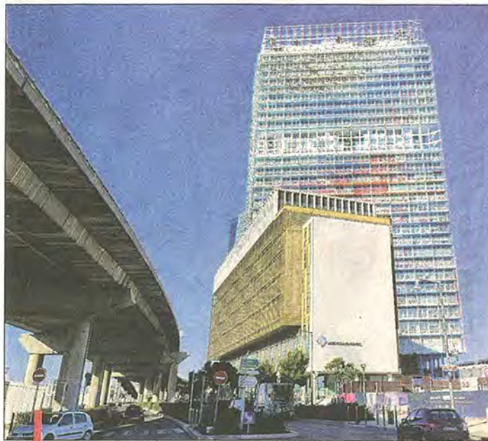
La nouvelle vitrine du WTC de la Chambre de commerce culmine à près de 130 m au-dessus de la Méditerranée. /PHOTO GEORGES ROBERT
