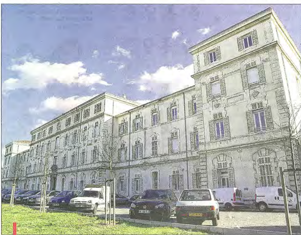
Premier espace que la Métropole entend acquérir : le bâtiment historique. / PHOTO ARCHIVES DAVID ROSSI
