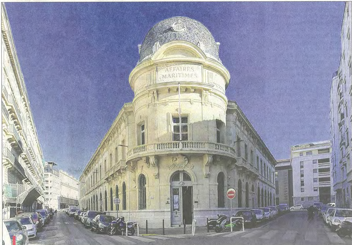
Au 25, rue des Phocéens, Habside a entièrement réhabilité l'ancien hôtel de la Marine et compte rénover la rue.
