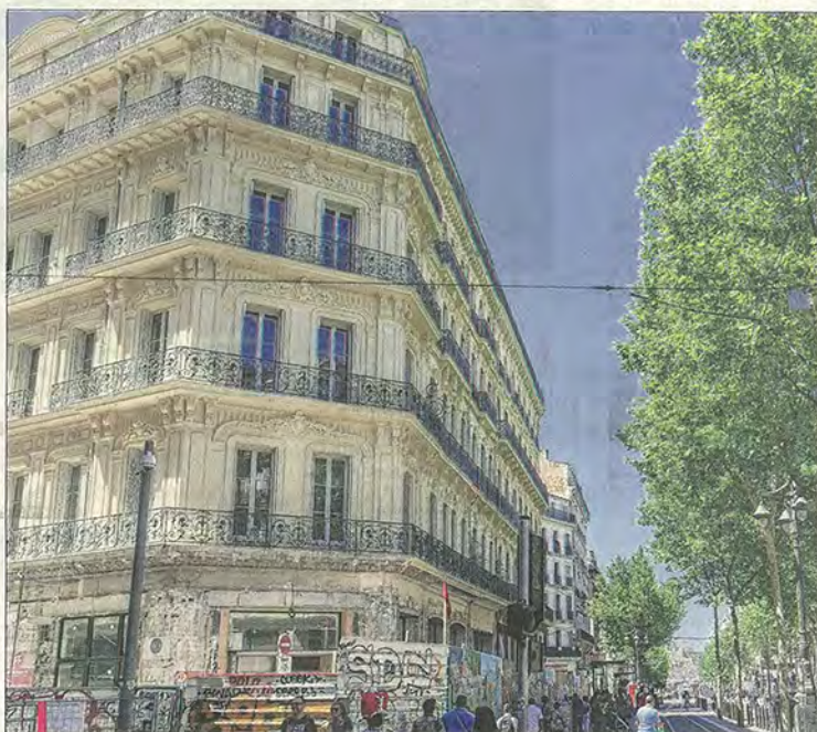
La façade haussmannienne a été conservée mais l'intérieur a été complètement vidé pour laisser place au chantier. Ci dessus, l'entrée principale de l'hôtel.
