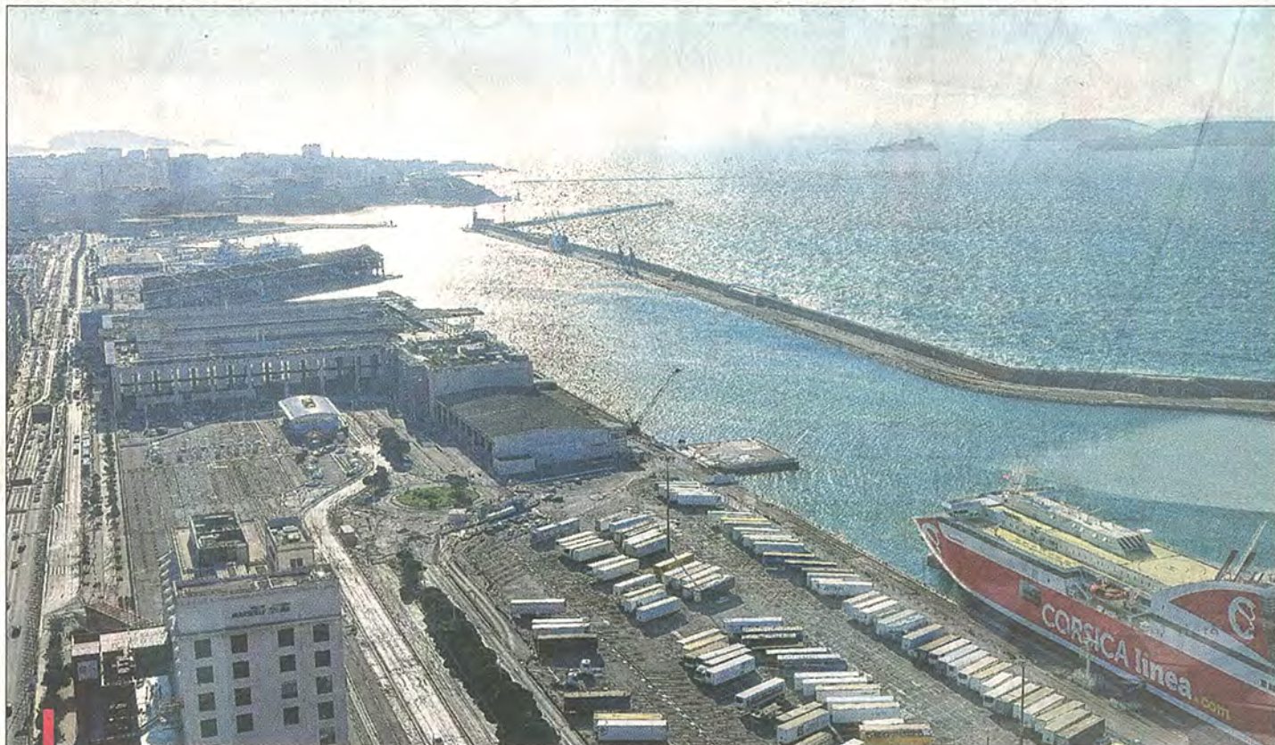
Vue générale du quai du Maroc et du lieu supposé d'implantation du futur parc, entre les Terrasses du Port et le Silo. / PHOTO GEORGES ROBERT
