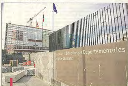
Entouré de grilles le temps de sa rénovation, le parvis des Archives départementales ne rouvrira qu'aux heures d'ouverture du site. /PHOTO FRÉDÉRIC SPEICH
