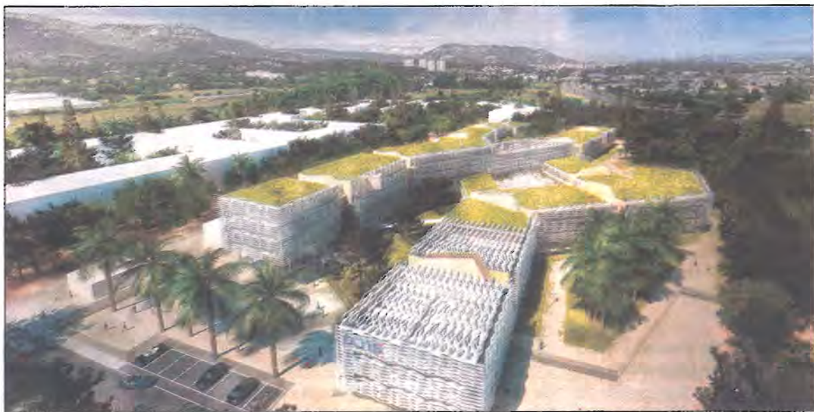
DCNS a confié la construction d'un bâtiment de 30000 m 2 pour y accueillir ses ingénieurs informatiques et clients internationaux à l'architecte Jacques Ferrier. (Docs Jacques Ferrier Architectures)
