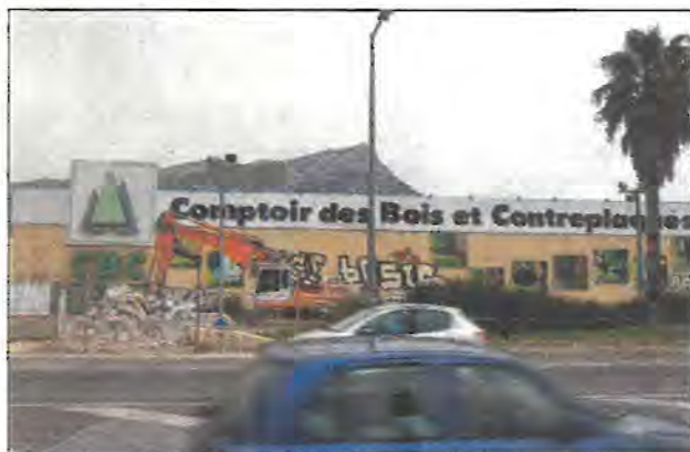
Les travaux de démolition de l'ex site de l'entreprise CBC sont aujourd'hui terminés. Une partie de l'habitat sera édifée sur ce site.
