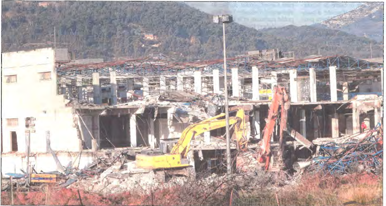
Six engins de chantier sont à l'œuvre depuis mercredi pour démolir le bâtiment. Il devrait avoir été réduit en gravas d'ici une quinzaine de jours. (Photo Patrick Blanchard)
