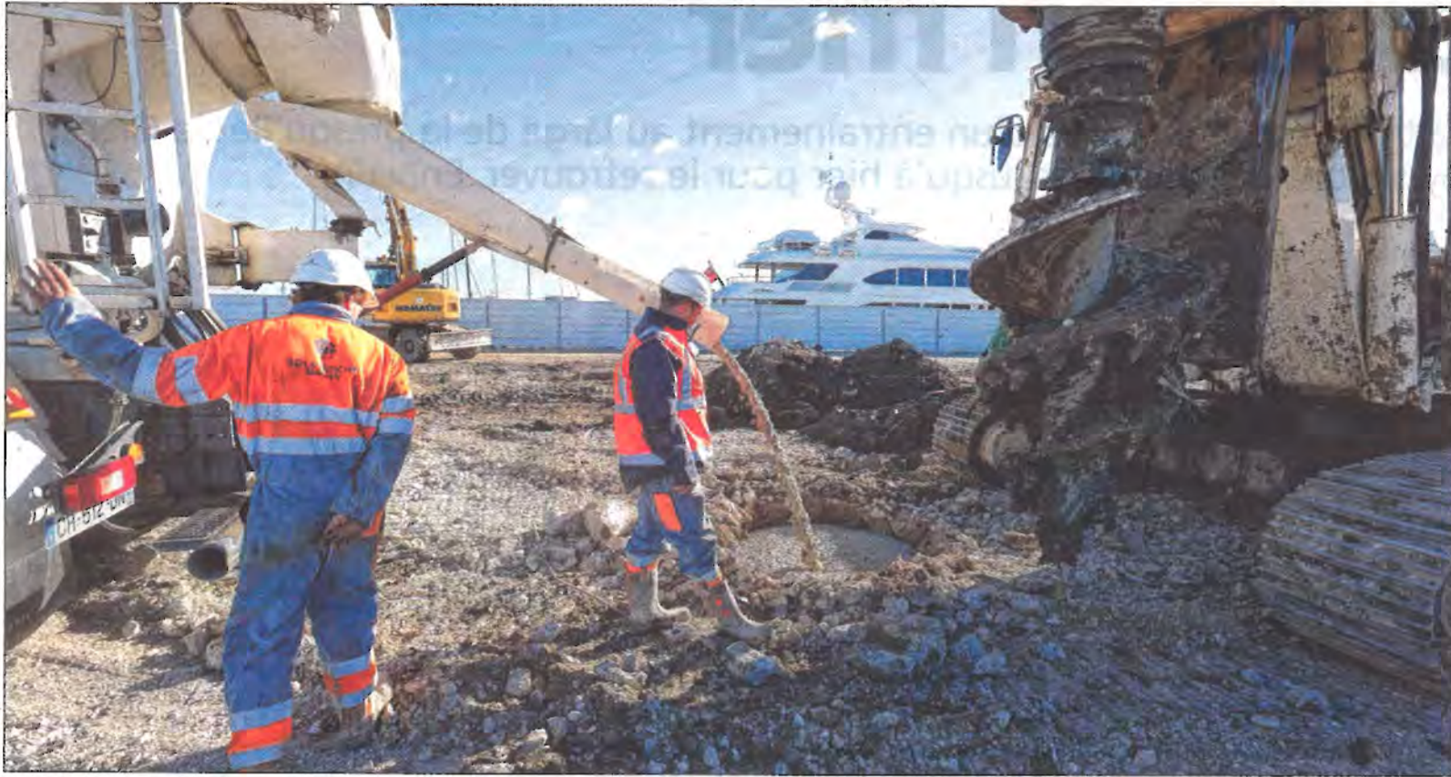
Sur le site des anciens chantiers, entre le parc de la Navale et l'Esplanade marine, l'heure est à la pose des soixante pieux qui soutiendront le bâtiment du casino, à vingt mètres de profondeur. (Photos Dominique Leriche)
