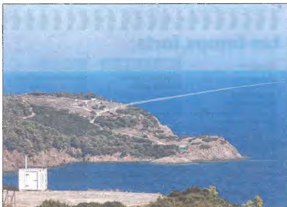
Le chantier pourrait démarrer à l'été prochain pour le premier palier à 1300 mètres, et d'ici à deux ans pour le second palier. (Photo Frank Muller)
