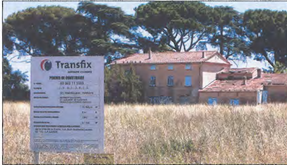
À la Grande Chaberte, Transfix réceptionnera sa nouvelle usine en 2015, sur un terrain de 4,7 ha. Cette bastide est vouée à la démolition. (Photo Dominique Leriche)
