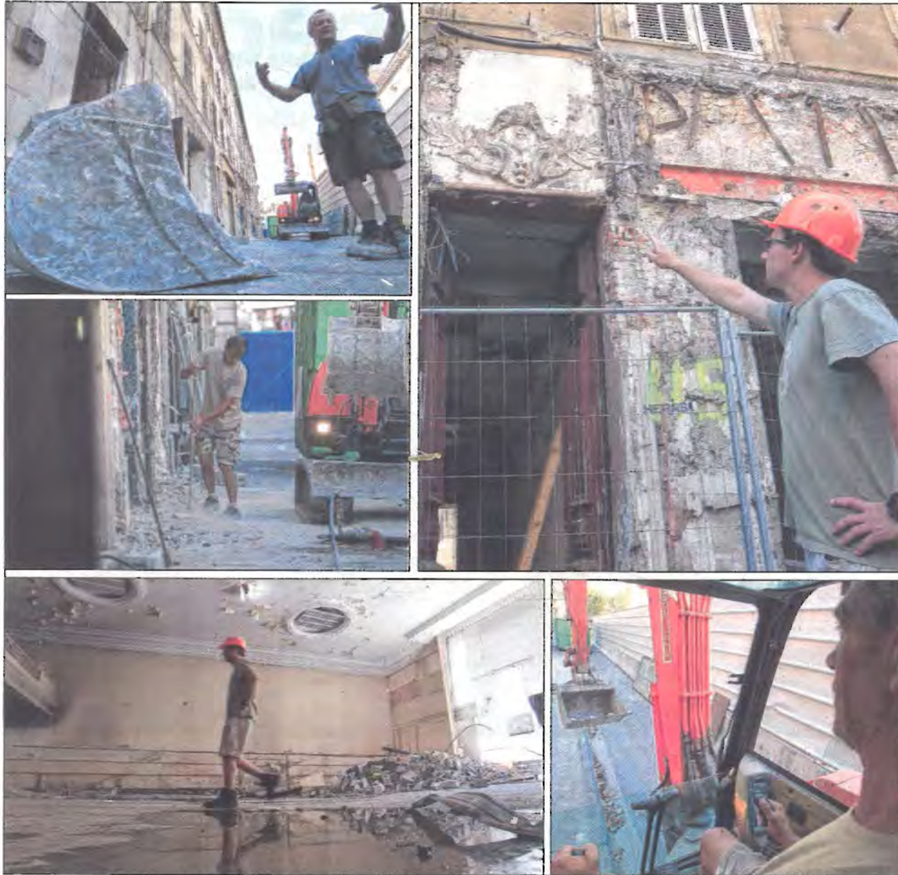
L'ancienne salle du cinéma l'Eldo, avec son balcon en fer forgé, aménagée dans l'ex-salle évangélique, va vivre un second et dernier clap de fin. (Photos Luc Boutria et vue infographie Thomas Criado)
