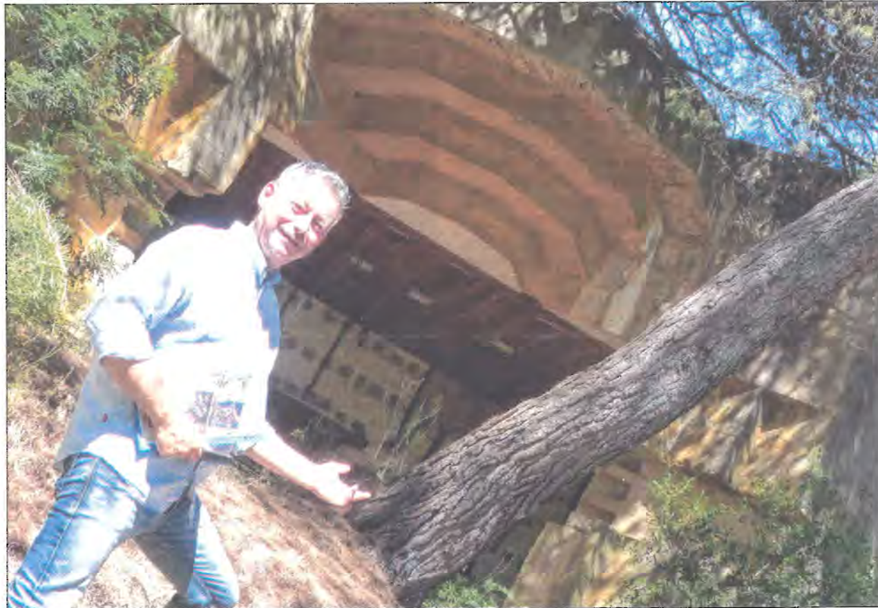
Daniel Gourlaouen devant l'une des batteries du Mittelmeerwall, le pendant méditerranéen du Mur de l'Atlantique. Durant les circuits, il met à disposition de nombreux documents et photos qui complètent la visite extérieure. (Photo C. R.)
