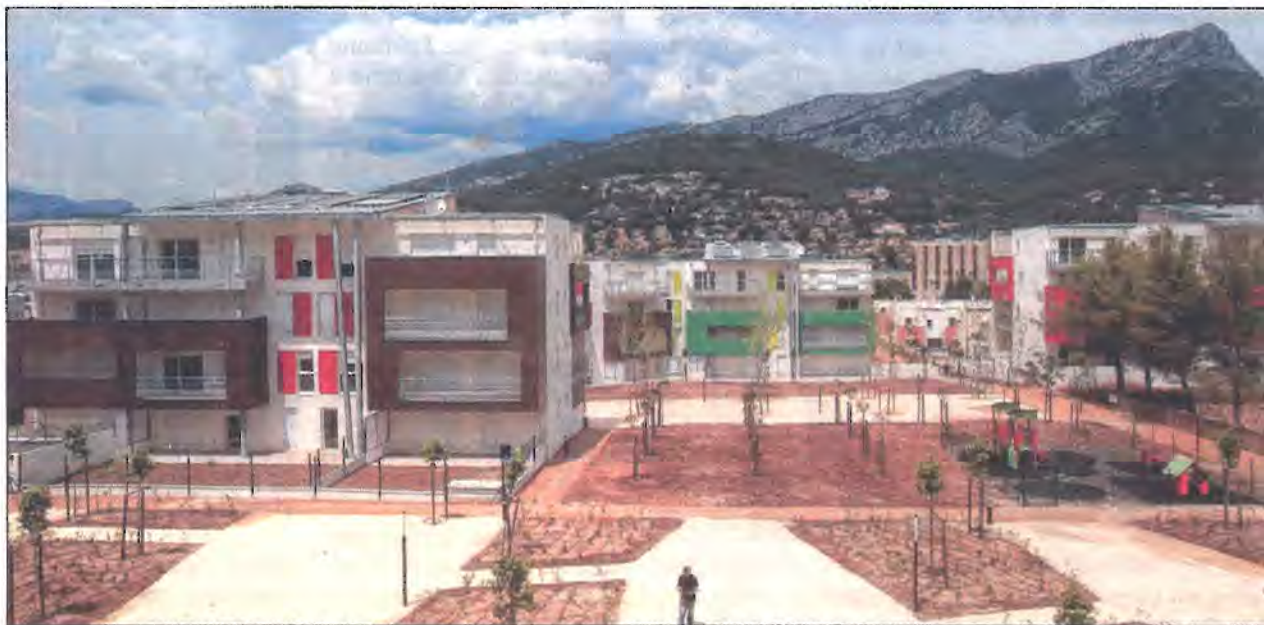
Dans leur conception du bâti, les architectes ont opté pour une harmonisation des volumes, des couleurs afin de ne pas différencier les logements sociaux et privés. (Photos Patrick Blanchard)
