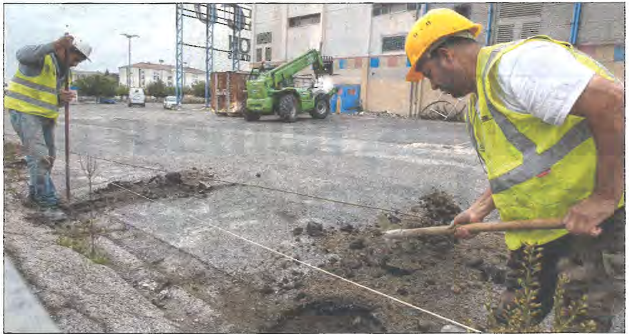
Le chantier de déconstruction a été lancé depuis la mi-octobre. L'ancienneté du bâti sous-entend la présence d'amiante, notamment à Barnéoud, qui sera le dernier bâtiment démoli. (Photos Luc Boutria)
