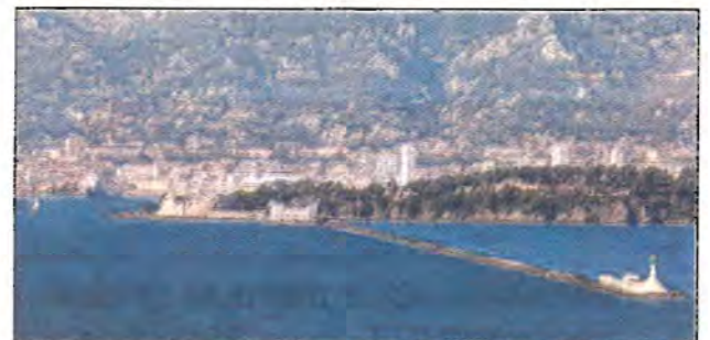
Le coût des travaux de consolidation rebute les partenaires militaires et civils. (Photo doc Magali Ruffato)
