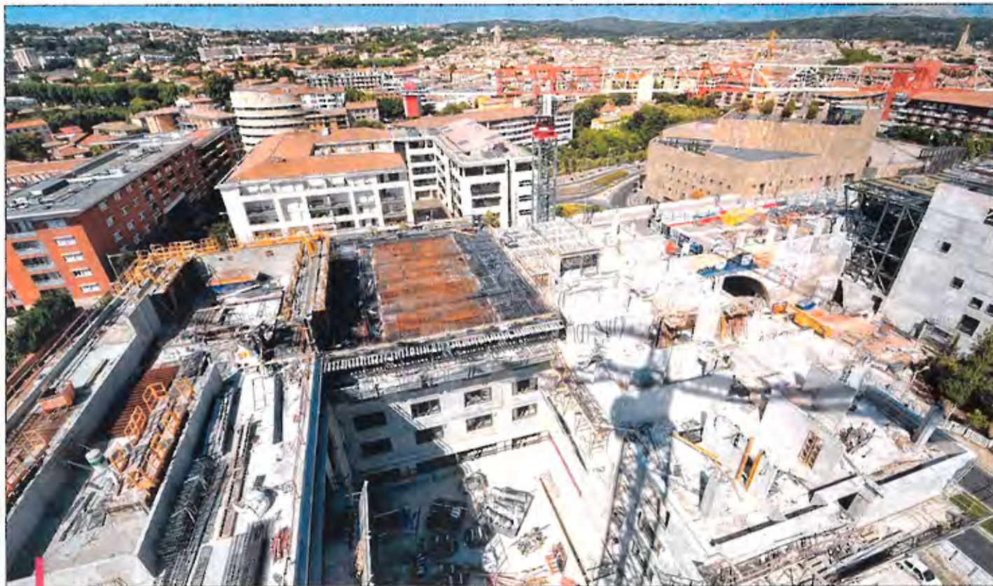
Le gros œuvre de ce futur hôtel 5 étoiles devrait être terminé mi-août. Livraison prévue en mars 2013.
