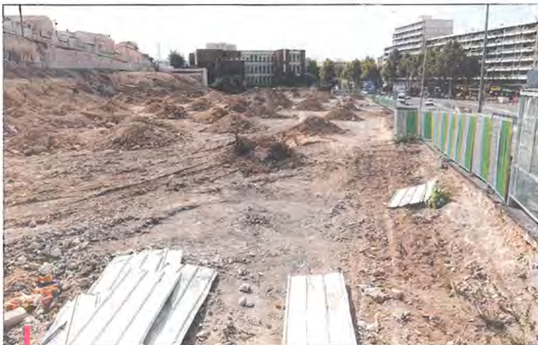
Après la destruction de la friche industrielle, l'heure est maintenant à la construction de l'ensemble immobilier de la Sogima.
