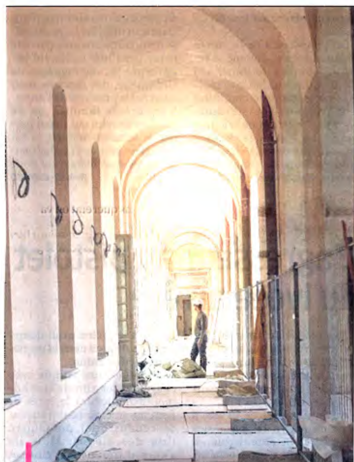
Les arcades de l'hôtel, minutieusement restaurées, surplombent une immense terrasse où sera aménagée une brasserie.
