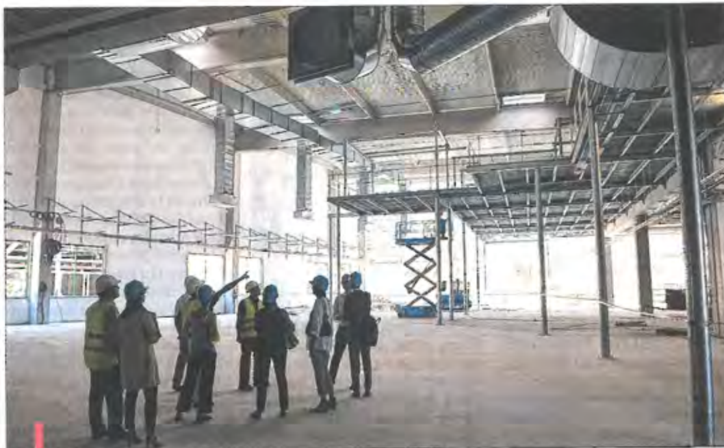
Le chantier pharaonique de la plateforme prend forme. Les unités de stérilisation, de restauration, la blanchisserie et le magasin des quatre hôpitaux publics marseillais y seront réunis. /PHOTO THIERRY GARRO
