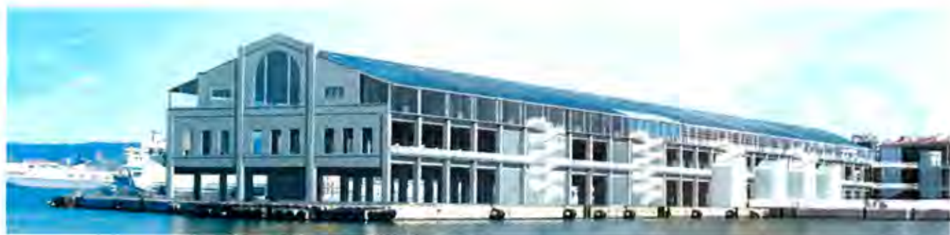
Le hangar J1 se rénove pour Marseille-Provence 2013
