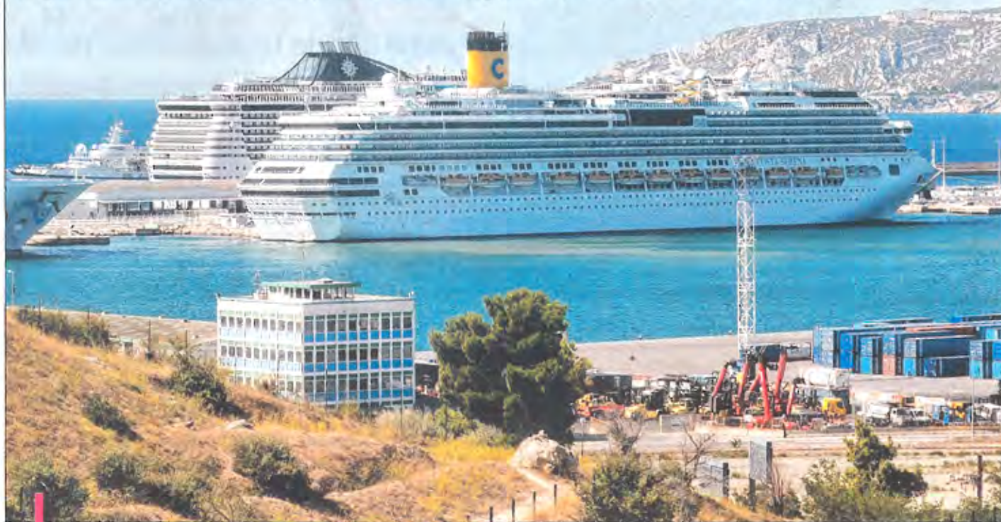
La passe Nord, face à l'Estaque, doit être élargie afin de faciliter l'accès des bateaux de croisière.
