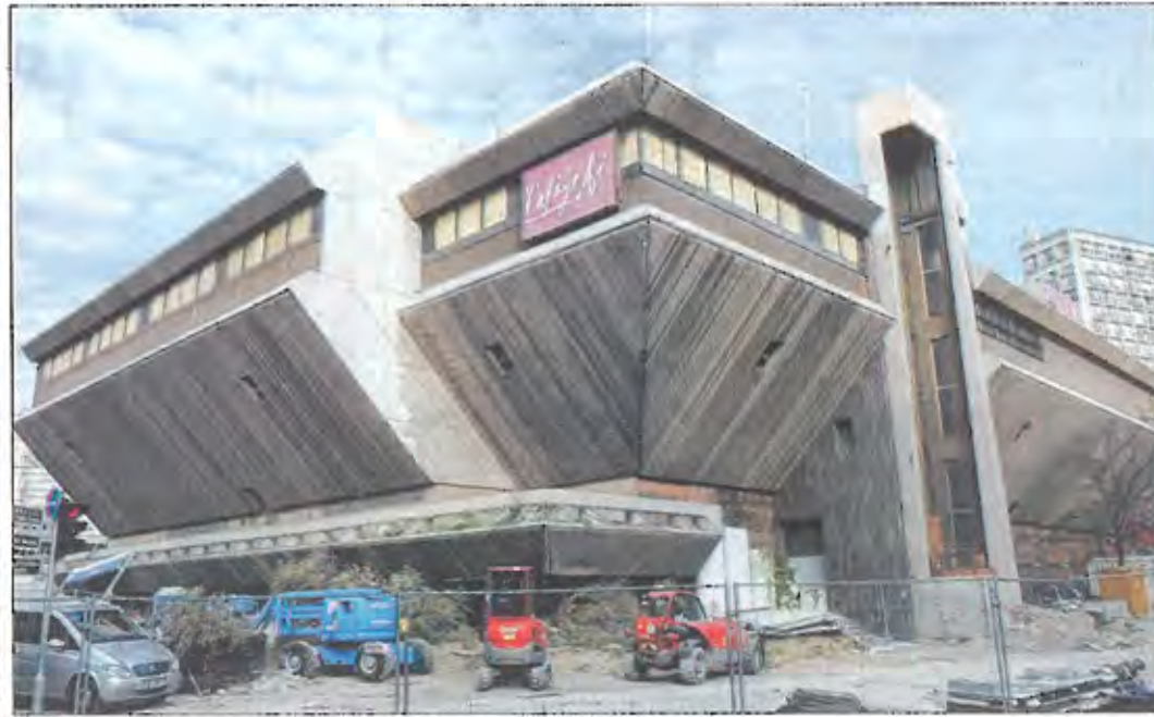
Perspective depuis l'angle rue Bir Hakeim rue Sainte-Élisabeth. Le nouveau toit reprend les techniques de l'aviation avec une structure en aluminium émaillé blanc. Ses courbes suivent le chemin du soleil. L'objectif est de protéger les grandes baies. Ingénieux donc. On est loin de l'aspect bunker du Centre Bourse actuel... À noter, la passerelle sera couverte et élargie. /PHOTOS DR ET PATRICK NOSETTO
