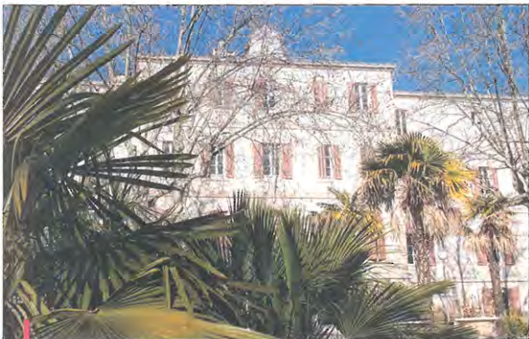
Dans ces locaux fermés depuis plusieurs années, la maternité de la Belle-de-Mai va renaître pour devenir en 2016 un club de vacances, le premier en milieu urbain des "Villages clubs du soleil". / PH. LP
