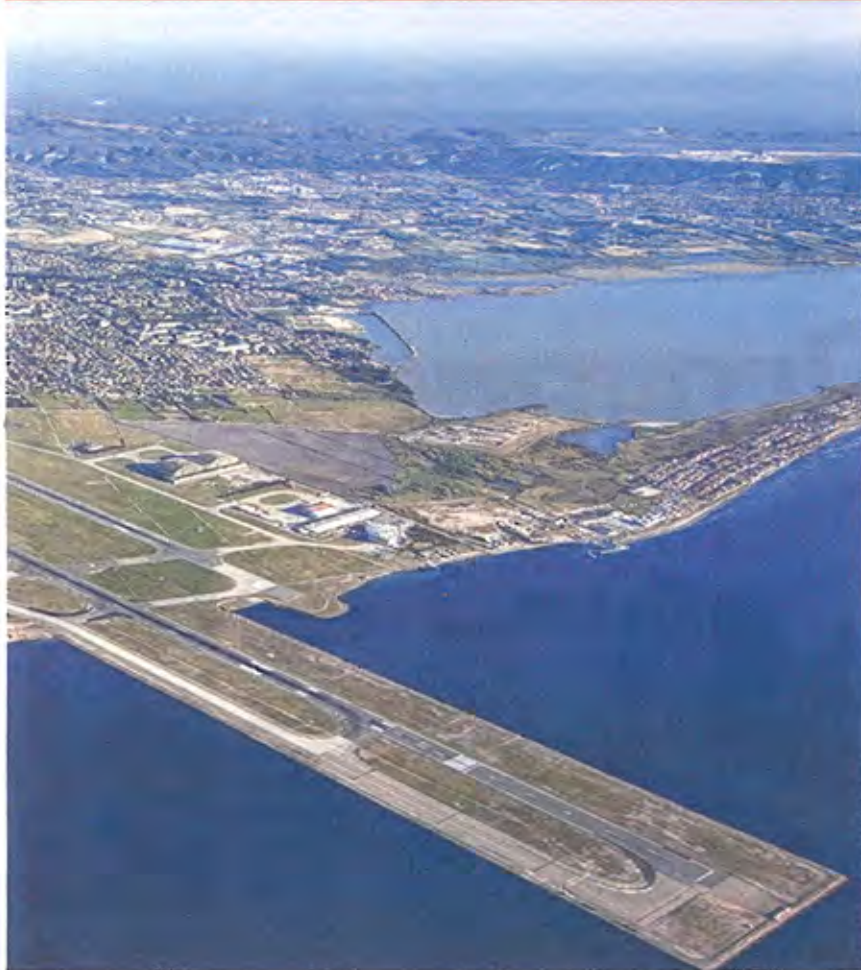
AÉROPORT MARSEILLE PROVENCE
