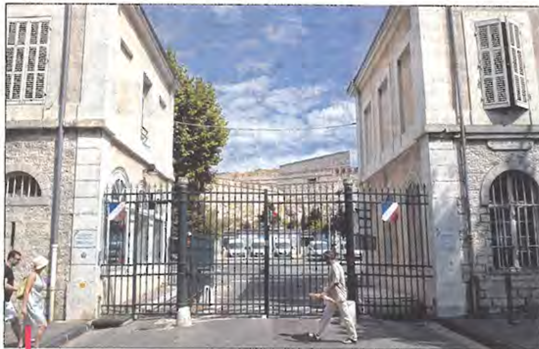
C'est dans l'enceinte de la caserne d'Aurelle que seront construits outre un collège, un ensemble immobilier de 110 logements et un local commercial, réalisés par la société Perimmo.
