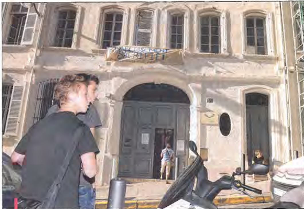
La Direction régionale des affaires culturelles a estimé devoir protéger ce bâtiment aux cinq fenêtres caractéristiques des bastides provençales du XVIII e siècle.
