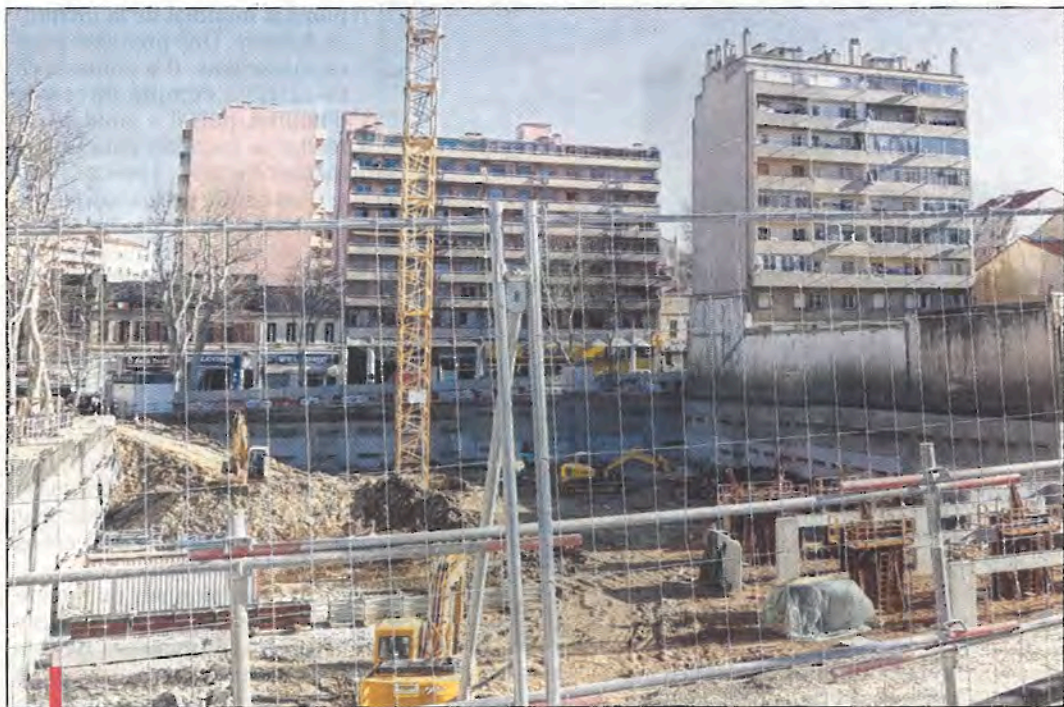
Quatre acteurs majeurs du logement social en France conjuguent aujourd'hui équilibre économique et haute qualité de construction. 600 logements minimum sont prévus en quatre ans. / PHOTO VALÉRIE VREL
