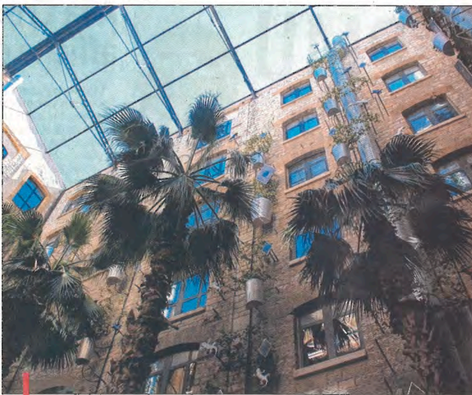
Les travaux d'aménagement des cours intérieures du bâtiment touchent à leur fin. Ici la cour C a été entièrement végétalisée avec des palmiers et des rosiers. /PHOTO FRÉDÉRIC SPEICH
