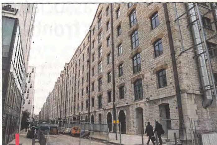
Le bâtiment des Docks, future promenade commerciale, et dont le chantier sera terminé en septembre prochain.
