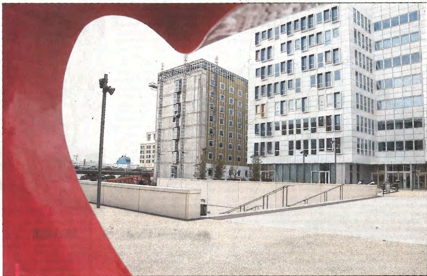
Avec Euromed Center, complexe de 70 000 mètres carrés, c'est l'immobilier mixte qui va être renforcé.
