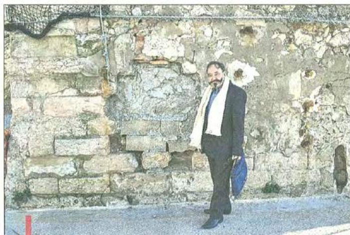
Le chantier de la plage a laissé des traces et des trous au bas de la Tour, bouchés au béton armé ou restés ouverts à tous les vents.
