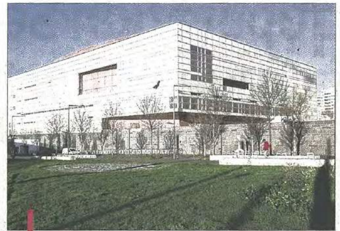
Les Archives départementales (boulevard de Paris) réunissent dans un seul bâtiment archives et bibliothèque de prêt.
