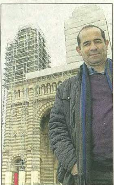
Pour François Botton, ce chantier devrait permettre d'être tranquille au moins 50 ans. /PHOTO DR
