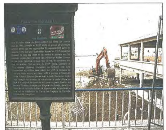
Les travaux de réaménagement des Catalans terminés, le Richelieu va sortir les Transats. /PH N.V
