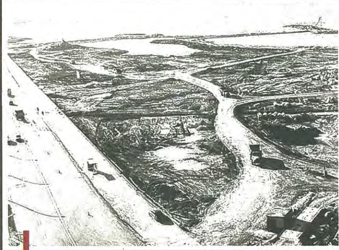
Les plages artificielles du Prado ont été aménagées sur 20 ha pris sur la mer, à l'aide des remblais du métro. / PHOTO ARCHIVES LP
