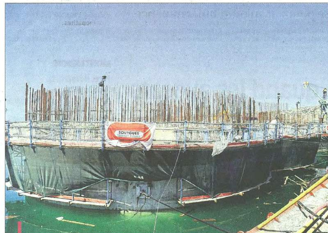
Constitué de deux demi-lobes de 15 m de diamètre, chaque caisson mesure 22 m de haut. Une fois lesté de béton, le plus lourd d'entre eux pèsera 15 000 t, soit plus de deux fois la masse de la tour Eiffel !
