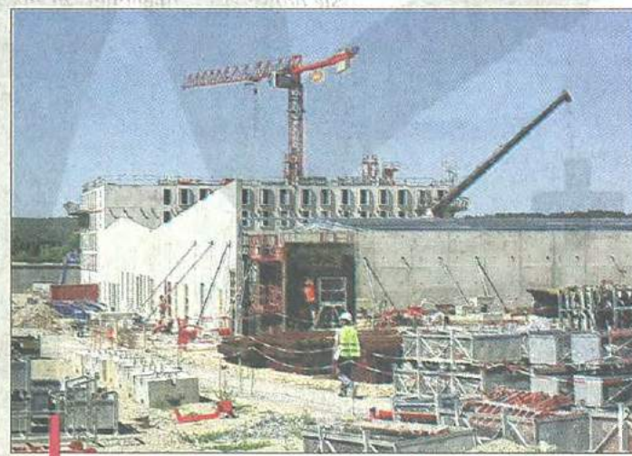
Le chantier avance à grands pas, ont accepté de dévoiler Nathalie Guillemeau et Denis Devriendt. / PHOTOS SERGE MERCIER
