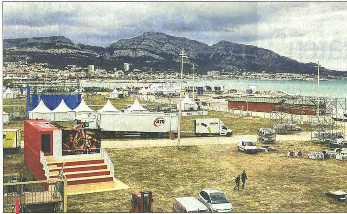
Encore en chantier, la deuxième fan zone la plus importante de France va occuper 40 000 m 2 d'espace. /PHOTO P.N.
