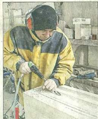
Les tailleurs de pierres travaillent dans l'atelier installé au pied de l'édifice.
