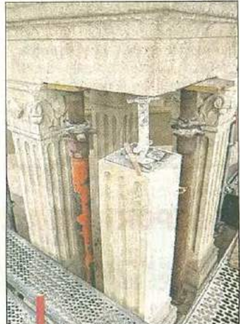
Certains de ces pilastres étaient tellement abîmés qu'il a fallu les refaire.
