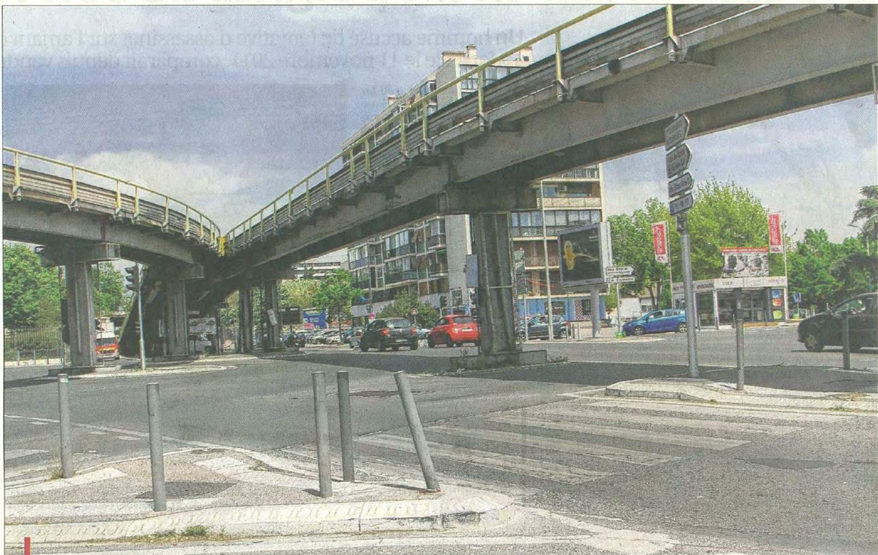
Le double défi de l'aménagement du secteur Ferrié-Schloesing-Rabatau : supprimer les deux passerelles et enterrer leur trafic pour ouvrir le passage au tram... / PHOTO DAVID ROSSI
