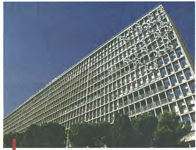
Inauguré en 1959, le CHU Nord est à l'époque "l'hôpital le plus moderne d'Europe". / PHOTO GUILLAUME RUOPPOLO
