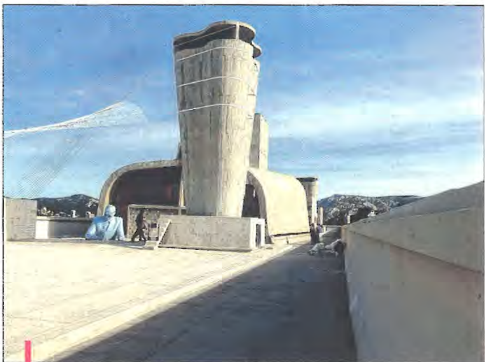
Le toit terrasse du bâtiment du boulevard Michelet, inspiré par les voyages de l'architecte à Alger.
