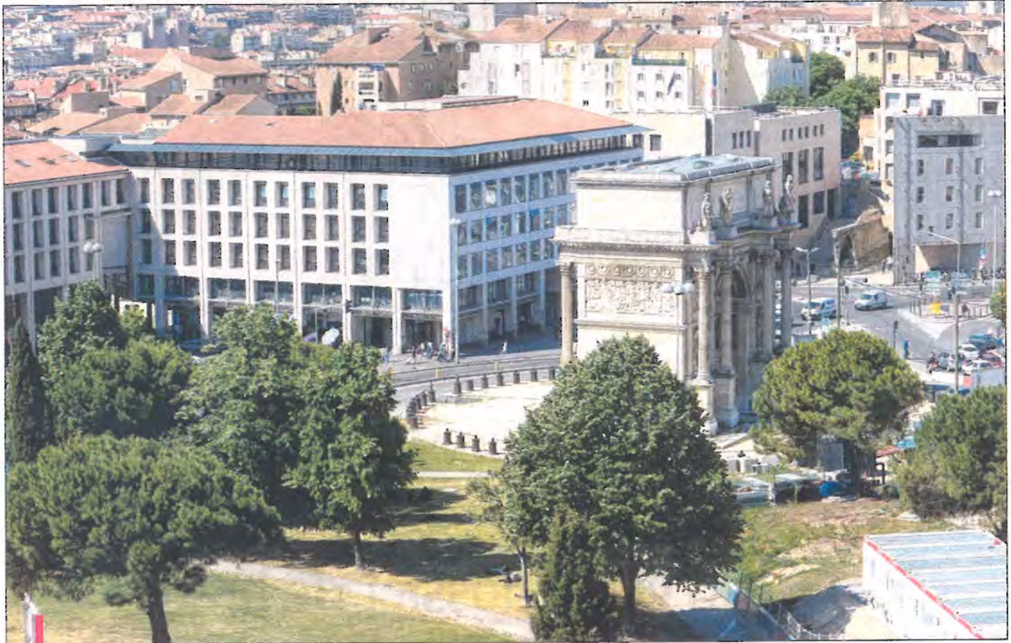
D'ici six ans, le campus va réunir l'École d'architecture de Luminy, l'École nationale supérieure du paysage, et l'Institut de l'urbanisme mais aussi le pôle Éco-gestion. De quoi redessiner un secteur et même une entrée de ville. / PHOTO GUILLAUME RUOPPOLO
