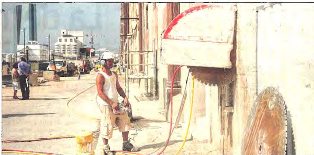
Tour de force aussi en septembre prochain : la cohabitation avec un autre chantier, l'aménagement de surface des Terrasses du Port, le colossal voisin... / PHOTOS DR ET NICOLAS VALLAURI
