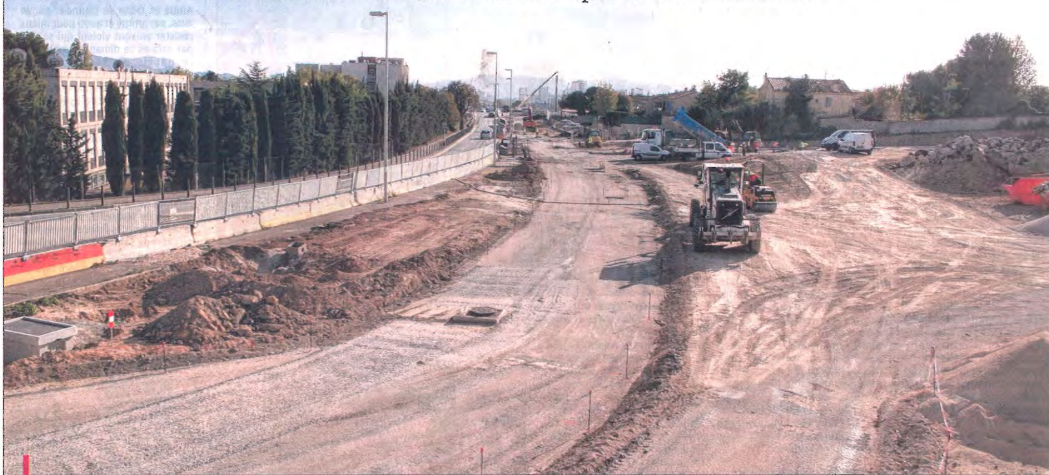
Entamé fin juillet 2013, le chantier devrait livrer un trajet tout neuf en juin 2014 pour une mise en service du TGB en septembre 2014. Coût des travaux : 60 M € TTC.
