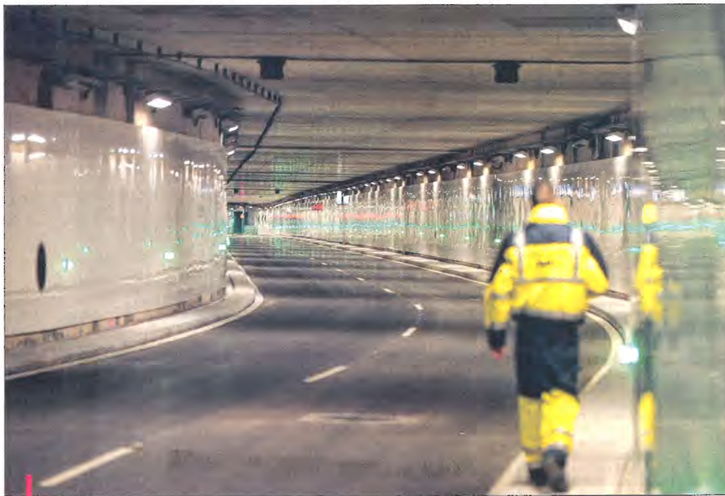
Le rayon de courbure de certains virages justifie la limitation de vitesse à 50 km/h (30 km/h dans les bretelles d'accès). / PHOTOS FREDERIC SPEICH
