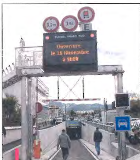
L'une des trois entrées du tunnel est située avenue Arthur Scott (10 e ).
