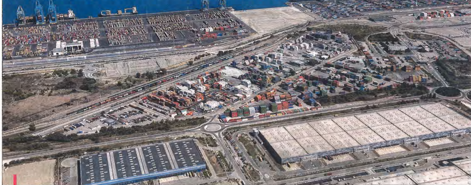
Une vue aérienne de la darse 2 et des terminaux conteneurs Fos 2XL. Avec au premier plan le site logistique Distriport. Au fond, le port pétrolier
