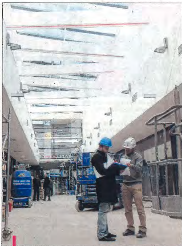
Les ultimes travaux se terminent à l'intérieur des 10 000 m 2 nouvellement créés. L'ouverture est prévue jeudi prochain.
