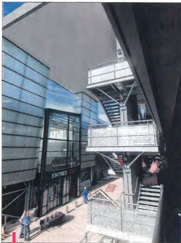
La nouvelle entrée principale est située à la sortie du parking à silo dont le volume a été porté à 1500 places. / PH NICOLAS VALLAURI
