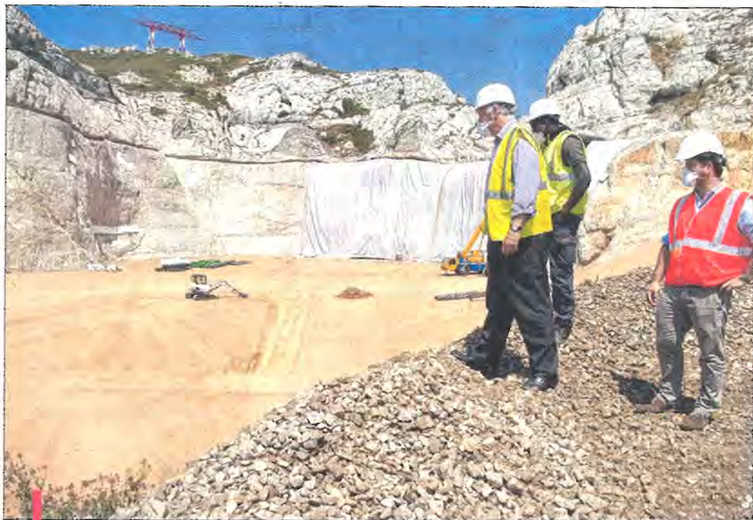
Derrière l'équipe de Recylex, l'alvéole bâchée où seront confinés les déchets de l'ancienne friche industrielle. Il faudra traiter 250 000 m 3 d'ici deux ans. Un chantier titanesque.
