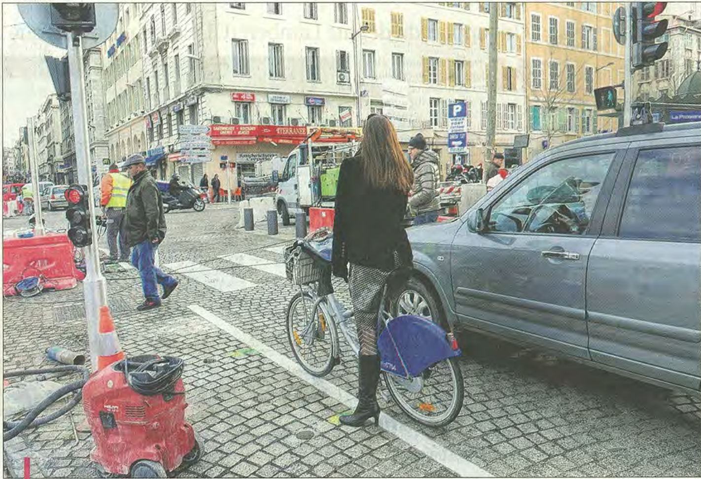
Les travaux effectués quai de Rive-Neuve n'ont pas amené la piste cyclable espérée par beaucoup.
