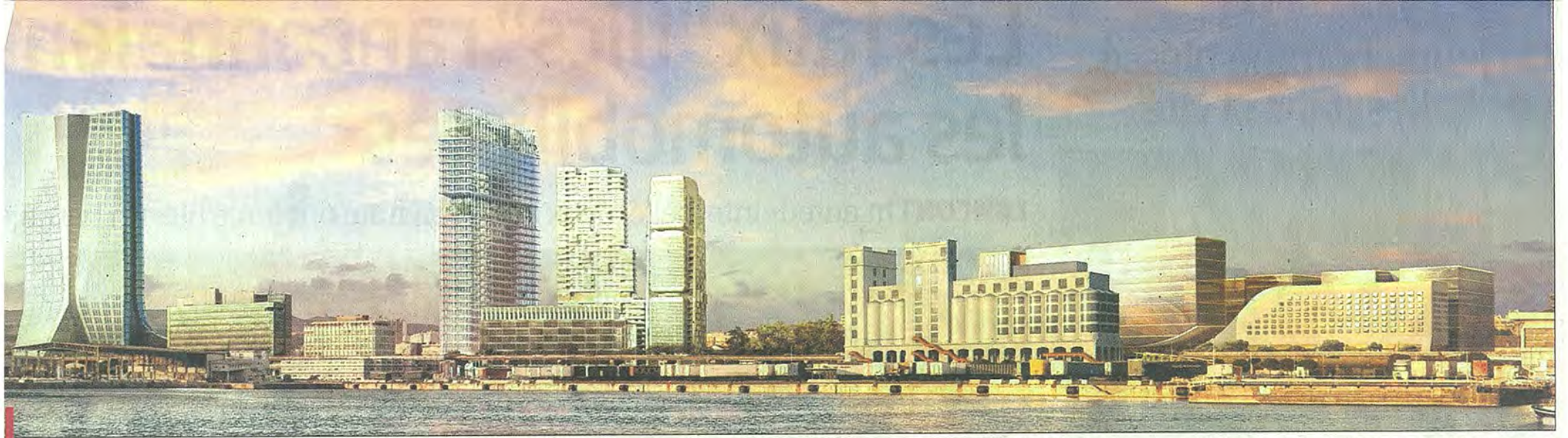
Le front de mer entre la tour CMA CGM et le Silo avec, au centre, le programme "Les Quais d'Arcenc" avec ses quatre immeubles : le Balthazar et les futures tours La Marseillaise, Horizon et H99.
