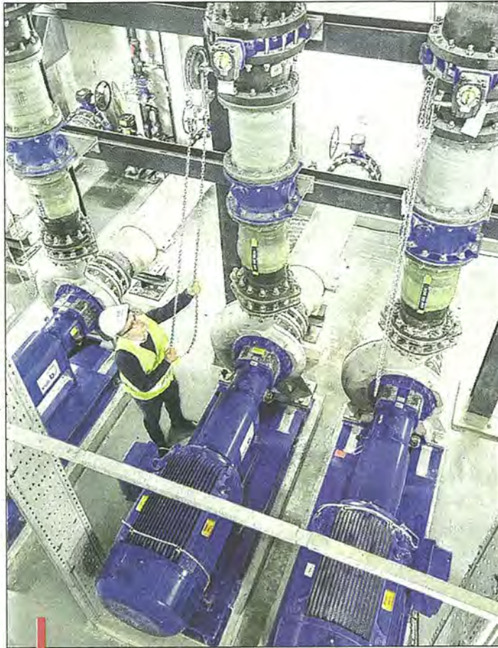
À gauche, la salle des pompes à eau froide. En haut à droite, le bâtiment d'enceinte de la centrale dessiné par l'architecte Roland Carta.
