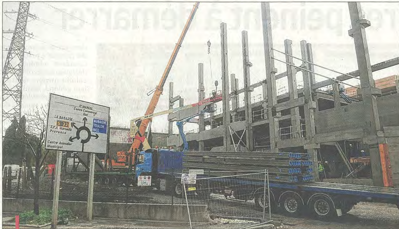
Situé sur l'avenue de Saint-Menet, à deux pas du cinéma "Les 3 Palmes", le chantier du nouveau magasin Decathlon devrait se terminer au printemps.
