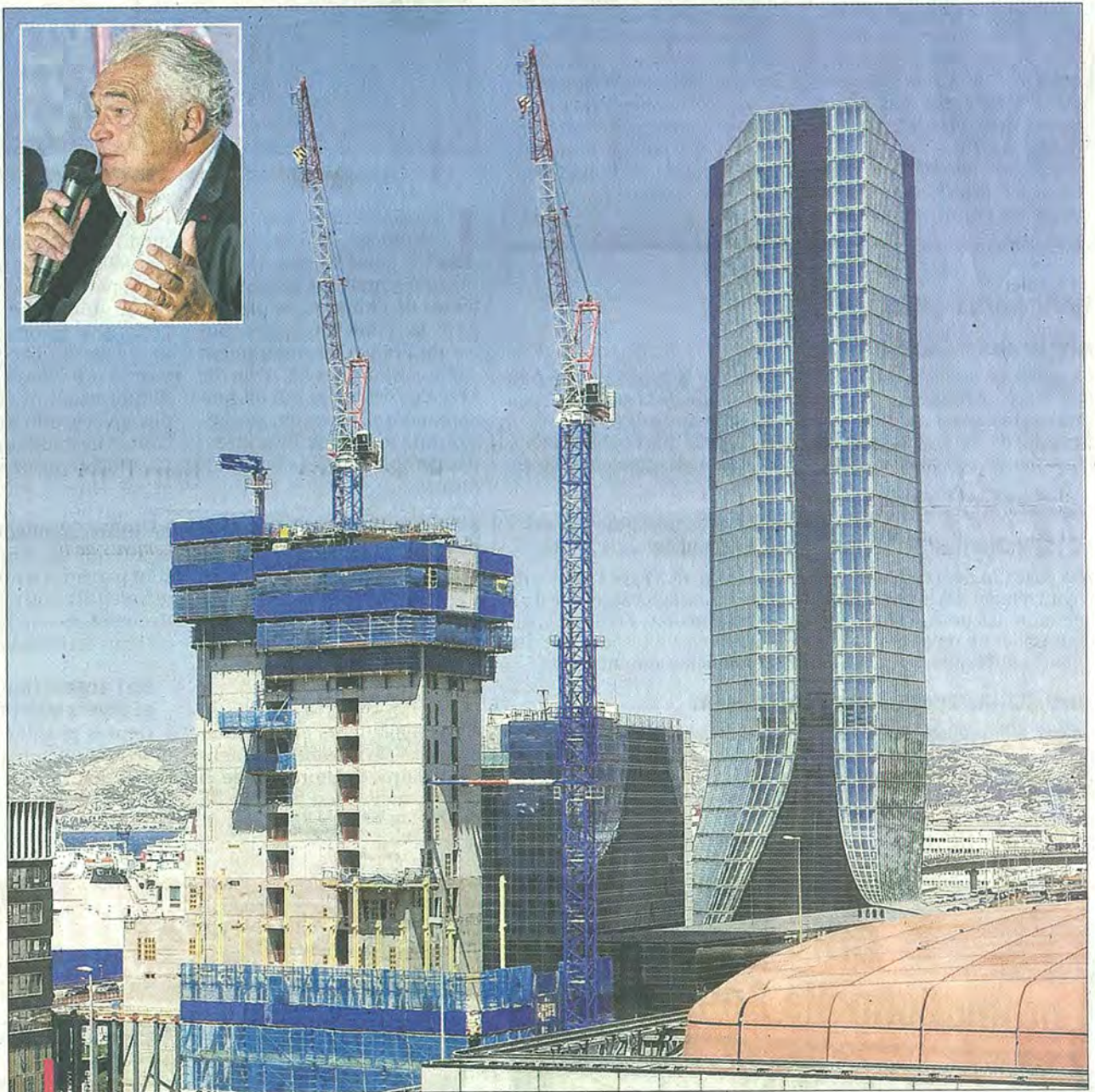
Au 20 septembre, le noyau central de La Marseillaise avait atteint son 13 e étage, soit un peu plus du tiers de la hauteur totale de l'ouvrage qui culminera à 135 m et comportera 31 niveaux. En médaillon, Marc Pietri.
