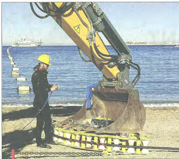
Arrivée du câble AAE-1 en provenance de Hong Kong sur les plages du Prado, en avril 2016.
