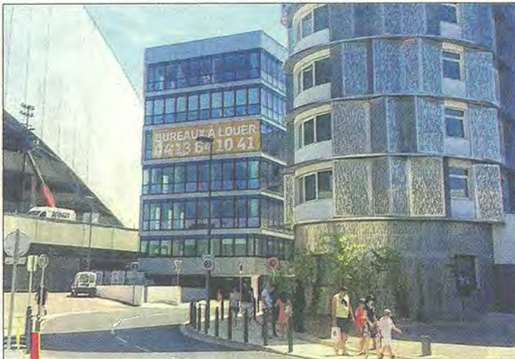
Ce sont pas moins de 12 000 m 2 de bureaux à louer qui ont obtenu le label Breeam, dans le nouvel écoquartier du stade Vélodrome. / PHOTO DR
