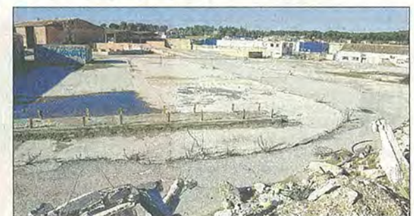
C'est côté Pennes-Mirabeau que le projet est prévu, dans le quartier des Rigons, de l'ancienne cimenterie. / PH. CYRIL SOLLIER
