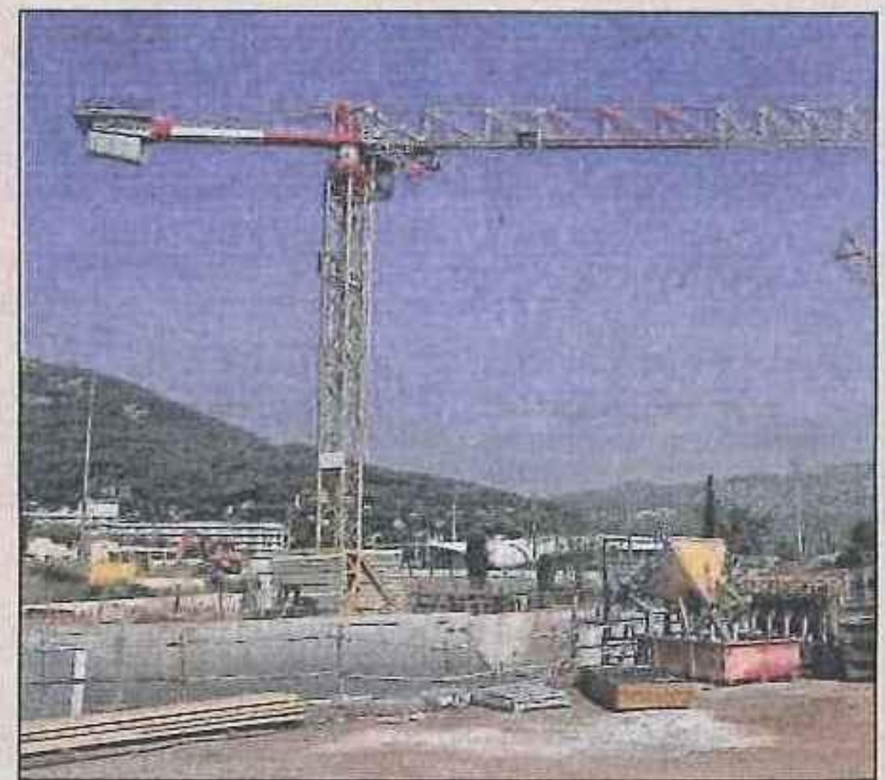
Le projet de l'AGPM à Sainte-Musse est la première offre de bureaux à être livrée dès l'été 2014.
