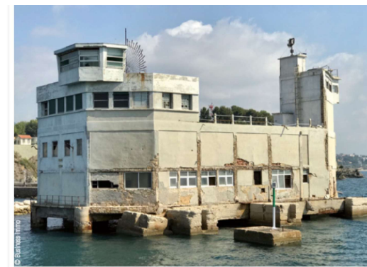
En poussant vers la pointe de Pipady, s'ouvre le deuxième lot, l'ancien môle des Torpilles. Un « navire » en béton amarré en bout de la jetée offrant une vue imprenable sur l'ensemble de la rade.
