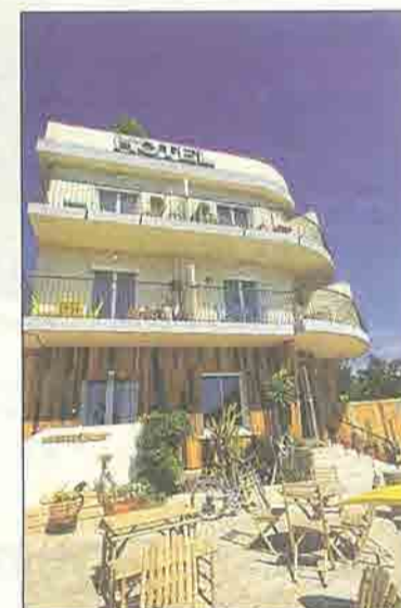
Du bois de palette reconditionné par un chantier de réinsertion a été utilisé pour les façades extérieures.
