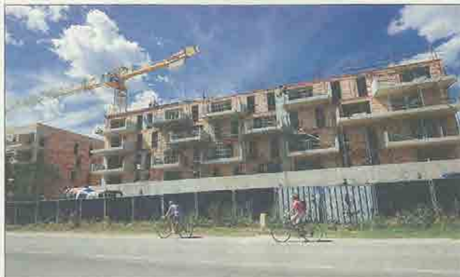
Les récents porter-à-connaissance de la préfecture énoncent des principes de constructibilité devant s'appliquer à toute nouvelle construction (ici un programme immobilier aux Vieux Salins) située en zone d'aléa submersion marine. (Ph. L. Boutria)
