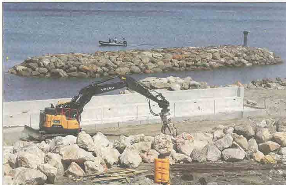
Le brise-lames positionné dans l'axe du chenal d'entrée protégera l'accès au port et le littoral, très exposés au vent et à la houle.
