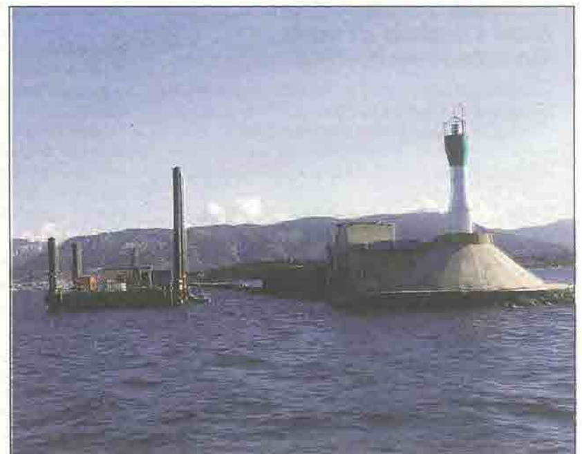
Le musoir à l'extrémité sud de la grande jetée va être entièrement refait et ses parties bétonnées remplacées par deux couches d'enrochements.
