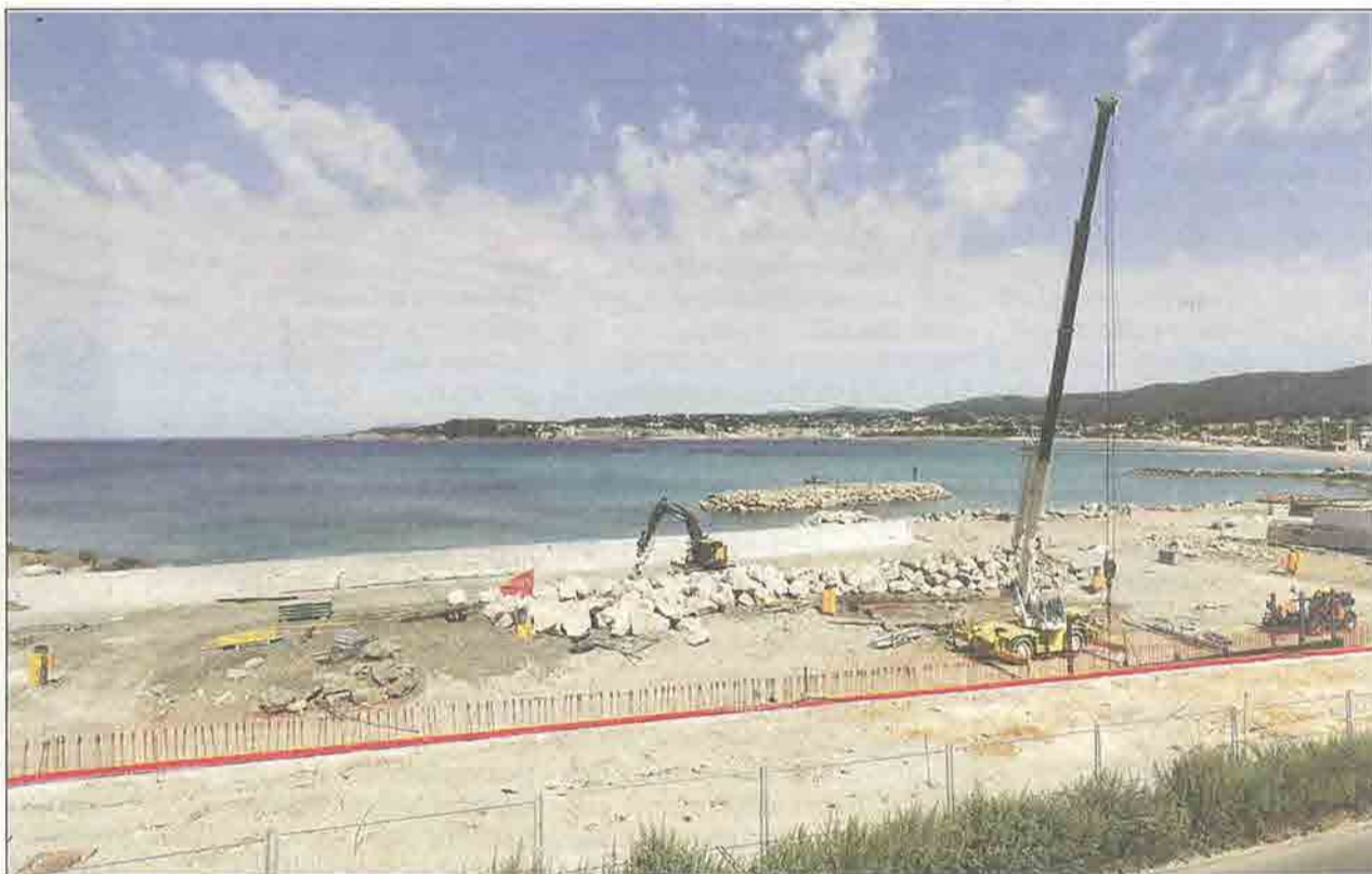
Dans le futur port de plaisance, la construction des quais en béton et de la digue avance bien.
