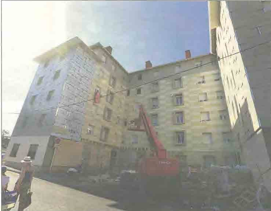
Il est procédé à une isolation extérieure couleur pastel des façades de ce grand ensemble.
