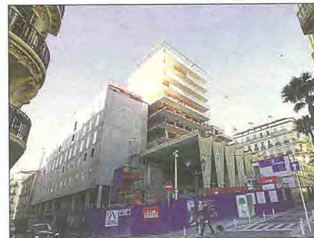
Le bâtiment définitif est prêt. A l'intérieur, les ouvriers s'activent. (Photos Patrick Blanchard)
