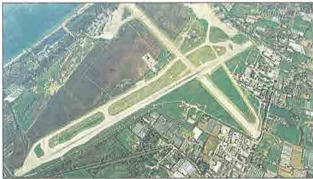
les travaux engagés sur les deux pistes de l'aéroport doivent durer 13 mois. (Ph. Base aéronavale Hyères)
