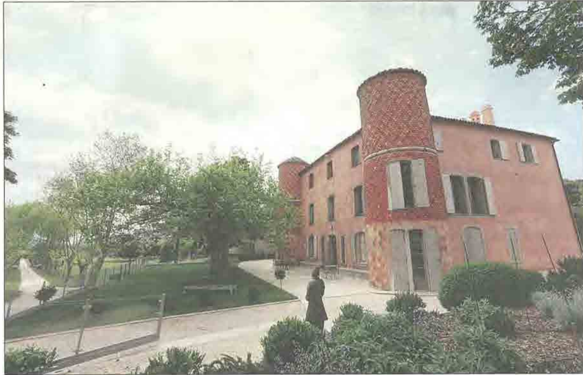
Le château du domaine de Tourris n'étant pas classé, René Gillet a pu le faire restaurer à sa guise, sans contrainte. D'où cet aspect à la fois provençal et bourguignon (au niveau des tourelles).
