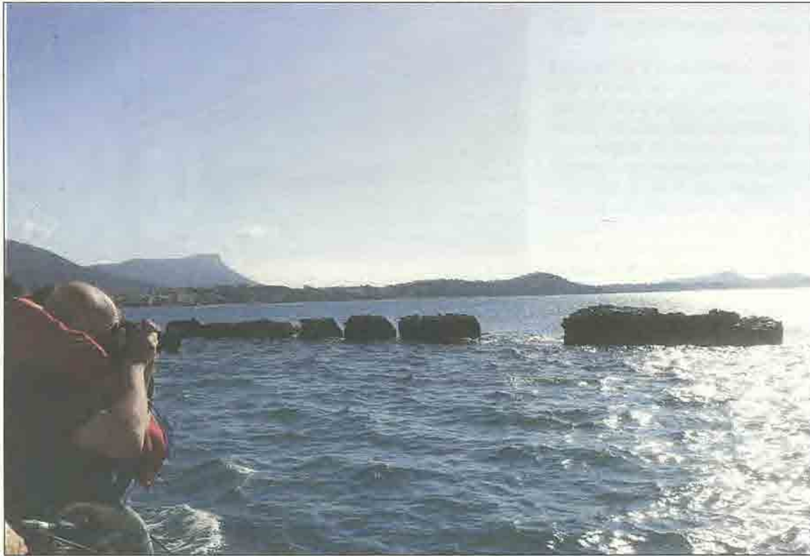
Sous les coups de boutoir de la mer, les blocs façonnés n'ont pas résisté malgré leur poids de 20 tonnes. Percée en trois endroits, la grande jetée a un réel besoin d'être restaurée. (Photo Patrick Blanchard)
