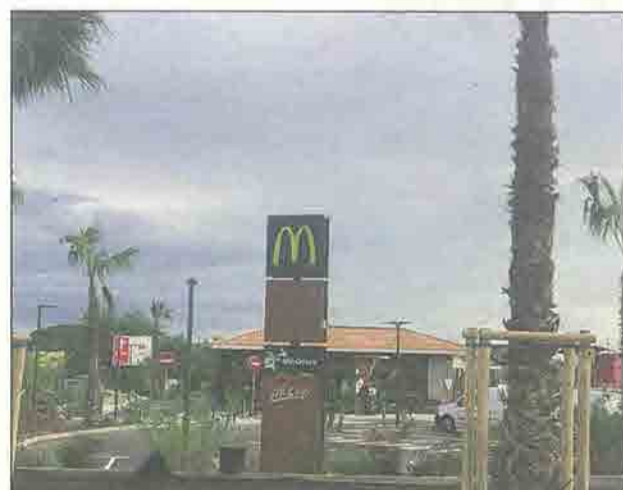
Les travaux débutés il y a 6 mois s'achèvent. (Photo P. P.)
