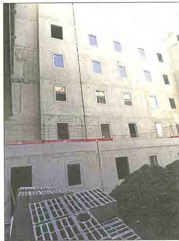
Les finitions sont en cours. Le chantier reste ouvert tout l'été !
