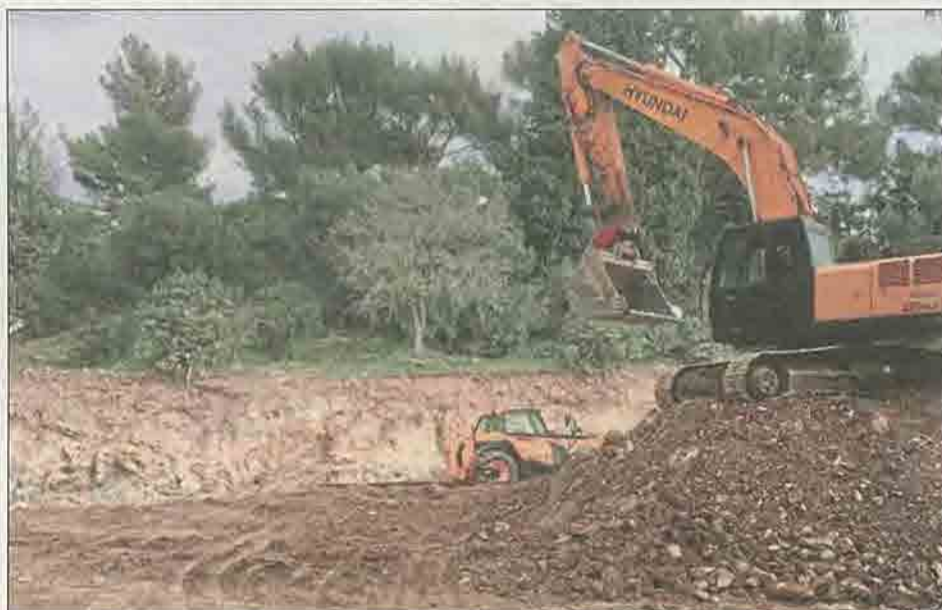
Les travaux pour la construction de la résidence sociale à orientation éducative de 43 logements et locaux annexes par la SA Erilia se poursuivent sur un terrain mitoyen à la Maison à caractère social La Valbourdine. (Photo C. P.)
