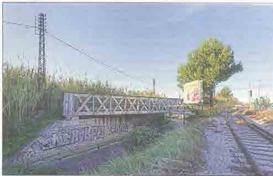
Fragilisé, le pont ferroviaire au-dessus de l'avenue Yitzhak-Rabin va être changé dans les prochaines semaines.
