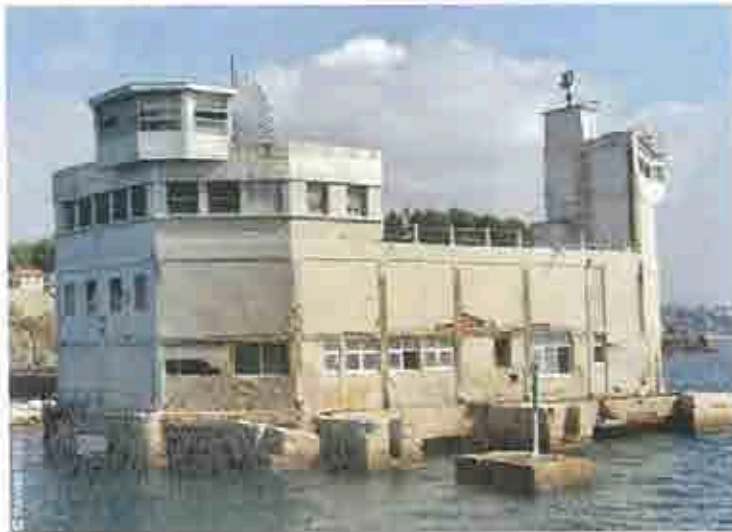
En s'appuyant sur le port de Pipady s'ouvre le deuxième lot, l'ancien môle des Torpilles. Un « navire » en béton amarré en bout de la jetée offrant une vue imprenable sur l'ensemble de la rade.
