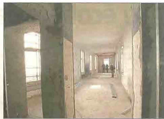
L'établissement accueillera aussi deux dortoirs de huit lits, avec un carré dédié aux équipages.
