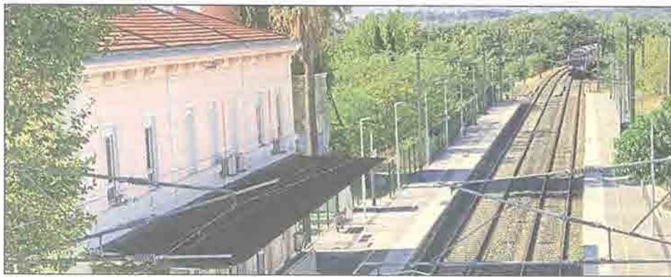
Avec seulement deux voies de Toulon à La Pauline, les TER ne peuvent pas être doublés par les TGV. A La Pauline, la SNCF prévoit de poser 2 voies supplémentaires
