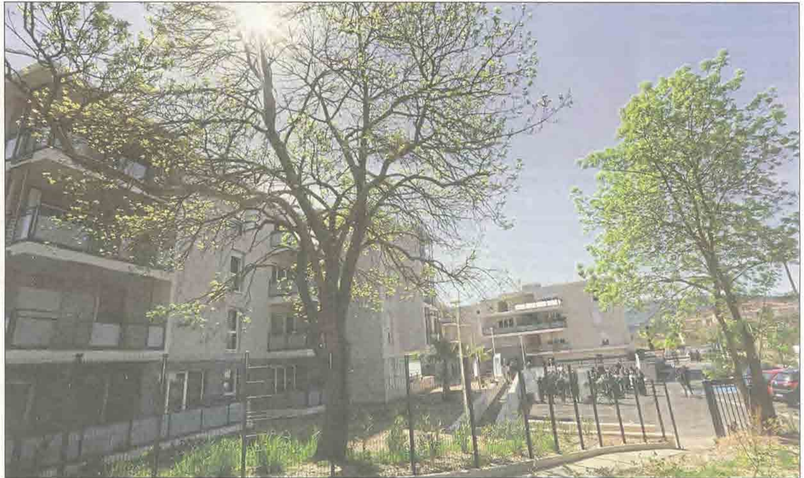
Un jardin est implanté à l'arrière de la résidence, qui compte 79 logements sociaux.
