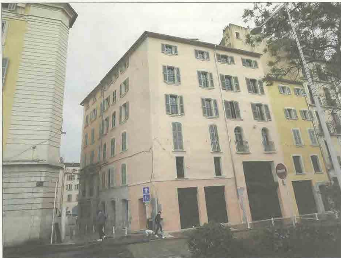
En rez-de-chaussée et au premier niveau de cet immeuble (à droite sur la photo) réhabilité, le bar-restaurant occupera une surface de 260 mètres carrés dont la moitié ouverte au public.
