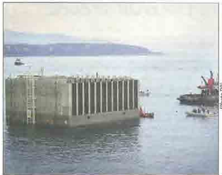
L'un des caissons géants qui seront remplis avec des graviers issus du Revest et transportés à Monaco via le port de La Seyne.
