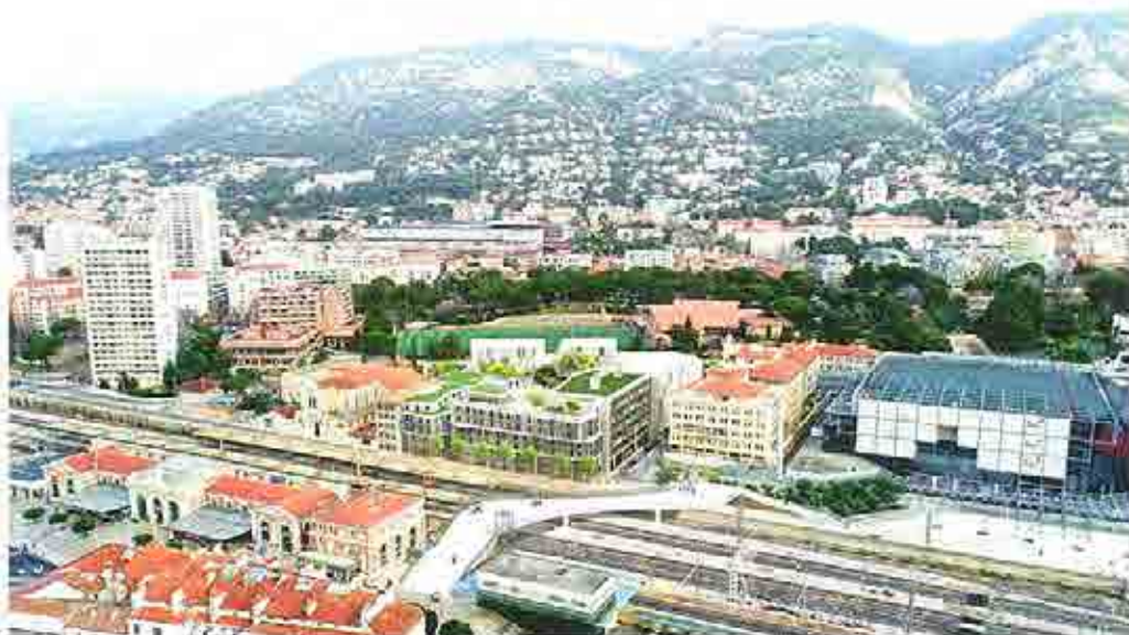
Vue d'ensemble avec la future passerelle.
