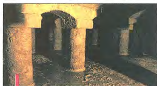
Sous le palais Longchamp, dans sa partie haute, des galeries abritent des réservoirs inutilisés.
