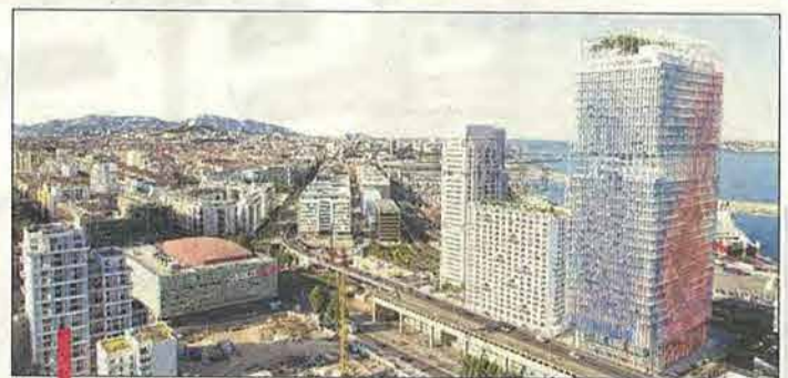
Le chantier de la Porte bleue (au centre) a débuté au pied de La Marseillaise. La tour H99 doit suivre (à gauche). /PIETRIARCHITECTES
