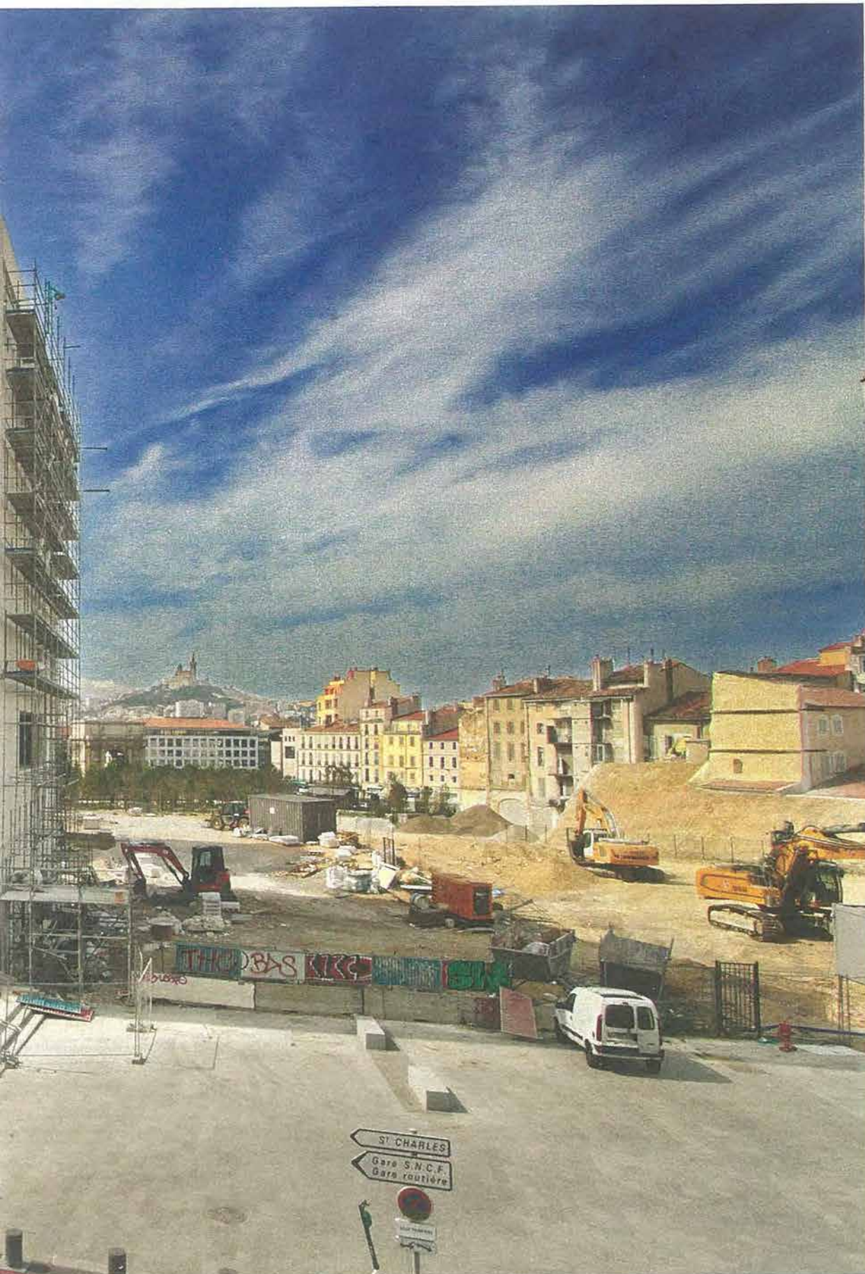
Le site où prendra place la résidence étudiante Sens, 83 logements pour 2 540 m 2 de surface de plancher.
