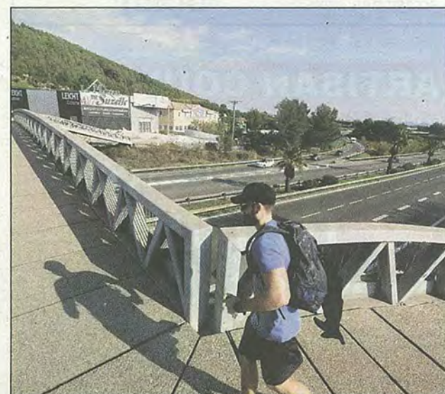
La passerelle à hauteur du bowling de La Garde sera démolie et reconstruite aux normes réglementaires.
