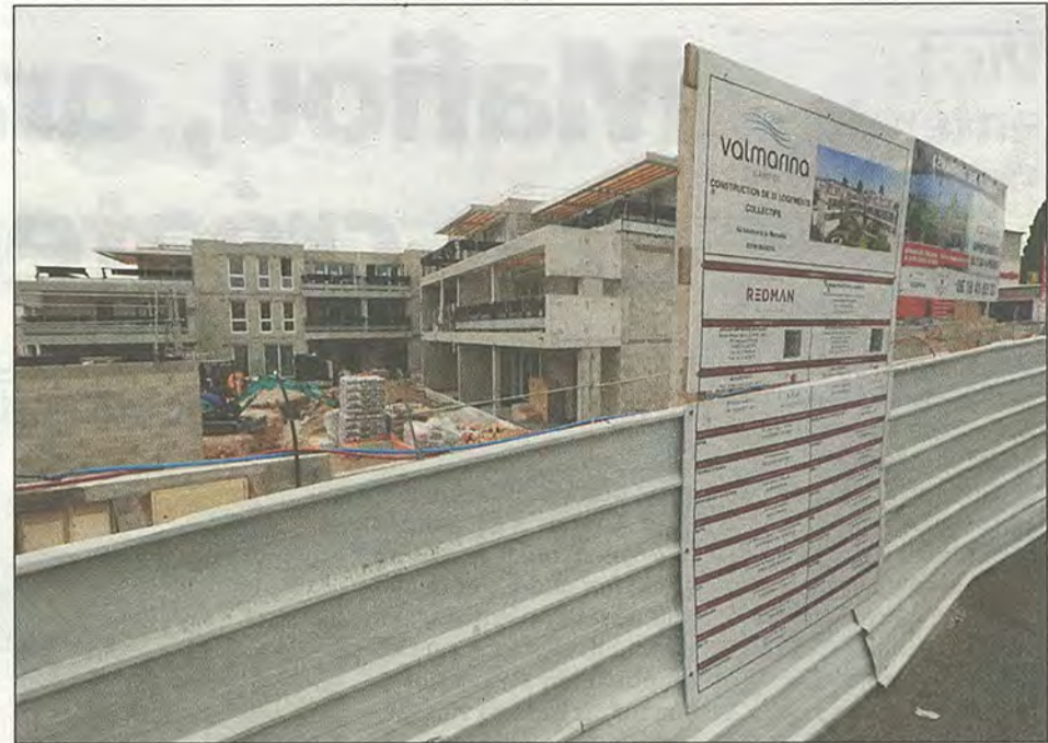
En train de sortir de terre, le projet Valmarina comptera 11 logements sociaux.
