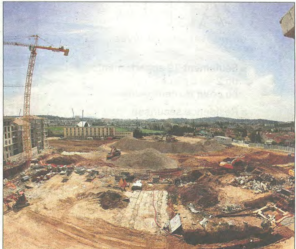
Sur site, la déconstruction des bâtiments est totalement achevée. Le béton appelé à être valorisé est concassé sur place. Cela servira notamment à la réalisation de la future voie, desservant l'écoquartier.
