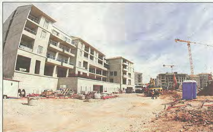
La construction de la résidence seniors dans le cadre de la seconde tranche va démarrer en avril. Livraison début 2018.
