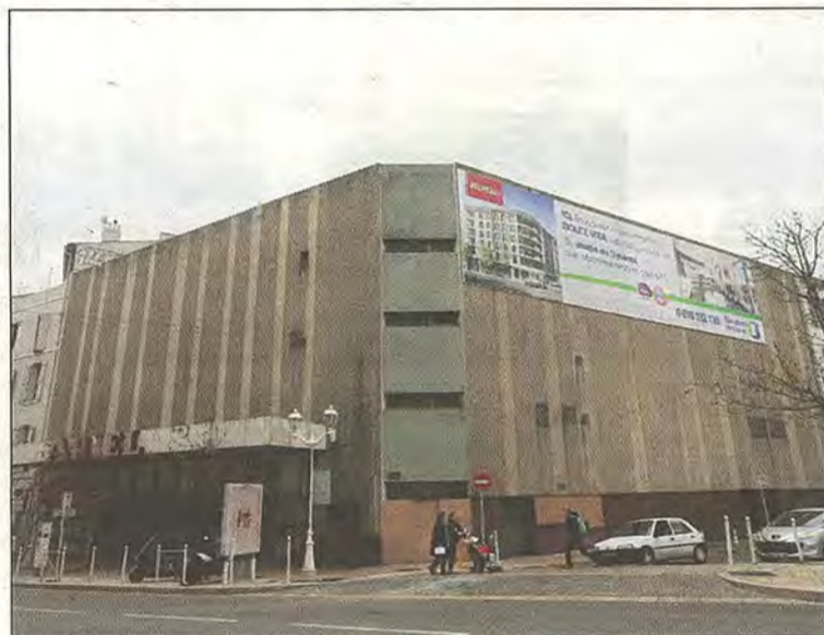
L'entrée du bâtiment a été murée par le promoteur en accord avec le propriétaire, à la suite d'intrusions. (Photo Patrick Blanchard)
