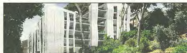
59 logements et bureaux en cours de construction. (Photo DR Jean-Marc Castella)
