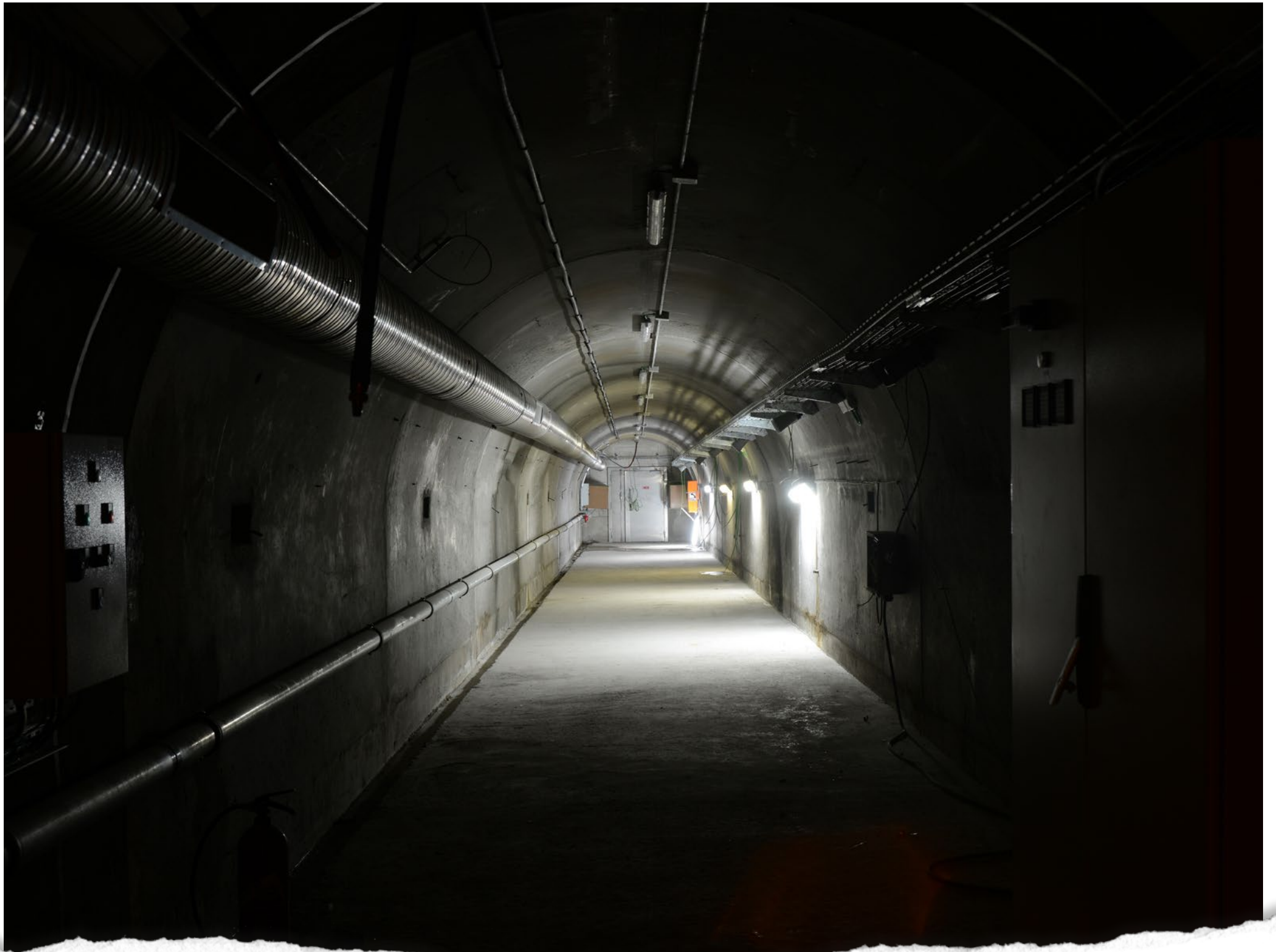
Tunnel technique reliant les tubes nord et sud.
