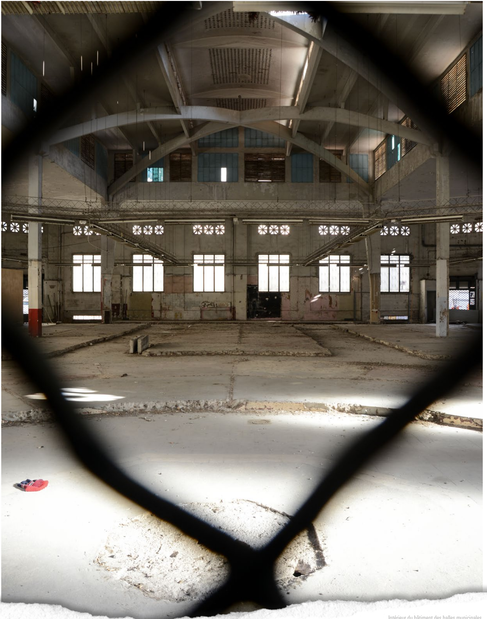
Intérieur du bâtiment des halles municipales.
